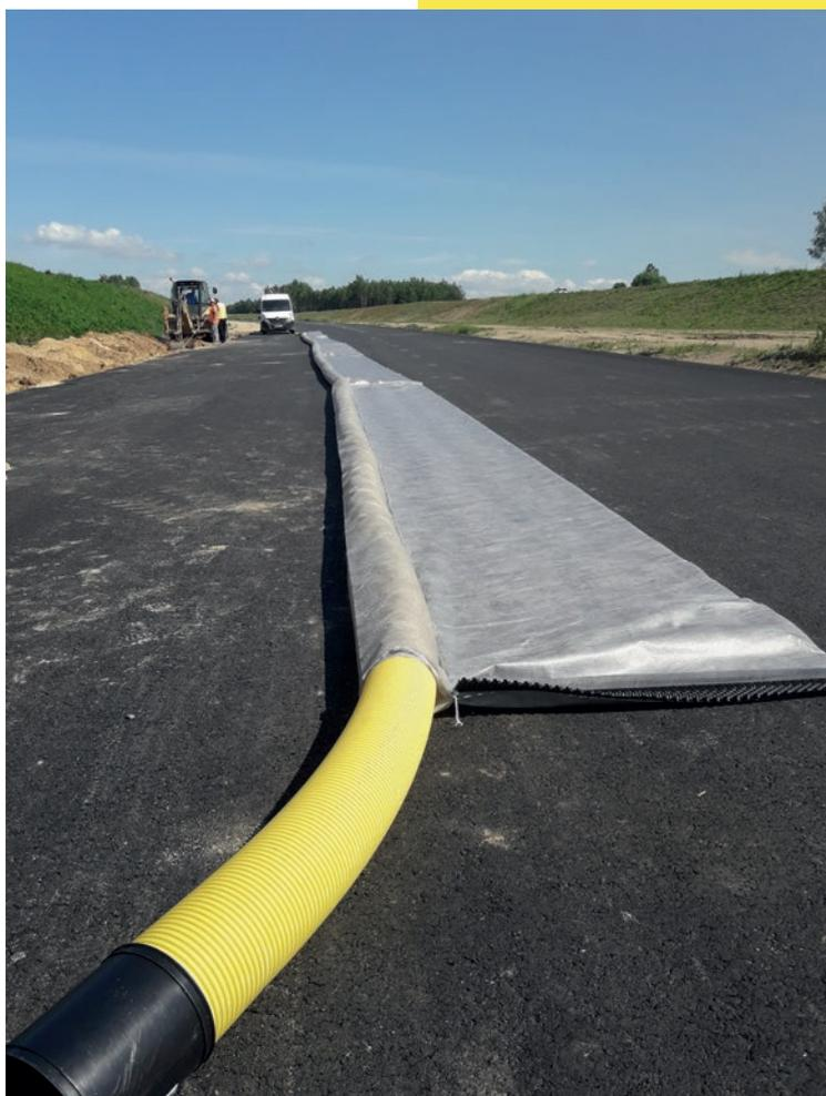
Le géocomposite est muni d'un manchon géotextile spécial dans la partie inférieure pour le positionnement et la fixation du tuyau de drainage.
