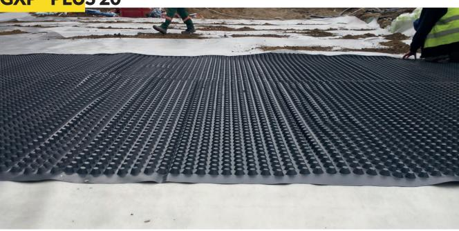
Die Membrane GXP® Plus 20 aus Polyäthylen HDPE angefertigt, Grammatur 800-1200 g/m², ist für einen mechanischen und hydraulischen Schutz von Tunnels, Gründächern oder anderen Untergrundbauten mit einem erhöhten Wasserdurchfluss.
