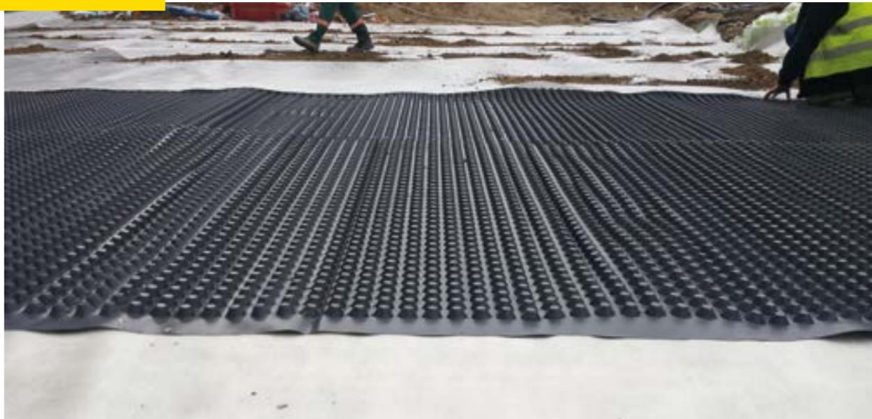
Fabriquée en polyéthylène haute densité (PEHD), avec un poids avec de 800 -1200 g/m<sup>2</sup>, la membrane GXP® Plus 20 est conçue pour la protection mécanique et hydraulique des tunnels, des toits verts ou d'autres structures souterraines avec un débit d'eau accru.
