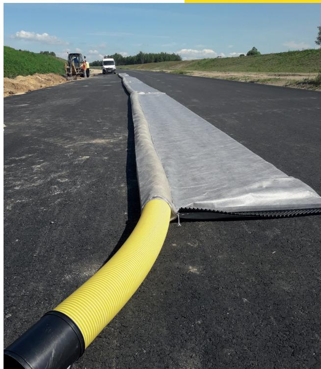
Die Matte ist mit einem speziellen Ärmel aus Geofaserrohstoff versorgt, was der richtigen Platzierung und Sicherung eines Drainagerohrs dient.
